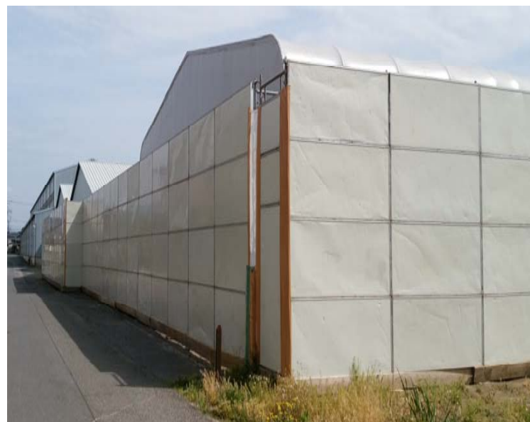
テントハウスを囲む仮防音壁
